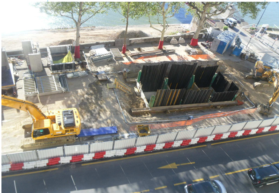
Vue globale de l'ouvrage
